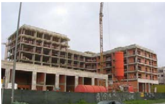
Figura 57 – Novas urbanizações no litoral de Vila Nova de Gaia, em Valadares.
