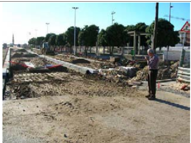
43 – Obras do programa Polis ainda em execução.
